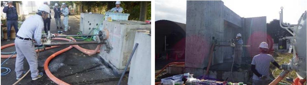
写真 2.11 削孔状況 (左: 1 m<sup>3</sup>, 右: 高強度)
