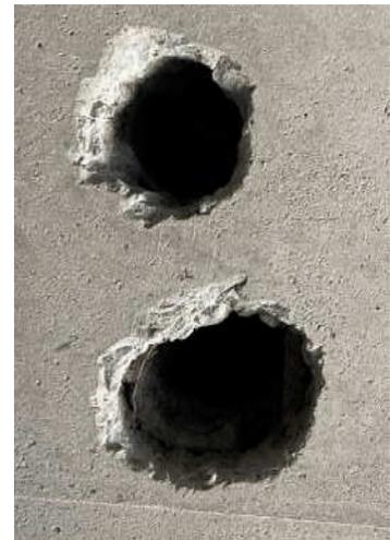
写真 1.4 WJ で削孔した孔口
