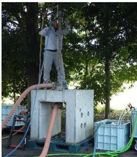
写真 2.5 削孔状況(下向き\_貫通)
