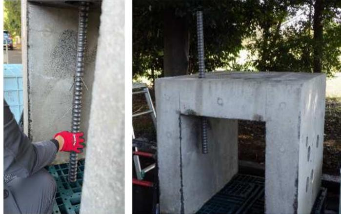
写真 2.8 D41×1m の装着状況と挿入後（留太郎 W2 個）
