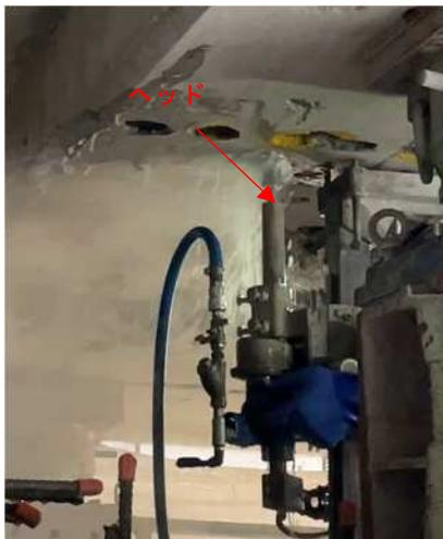
写真 1.2 WJ での削孔状況
