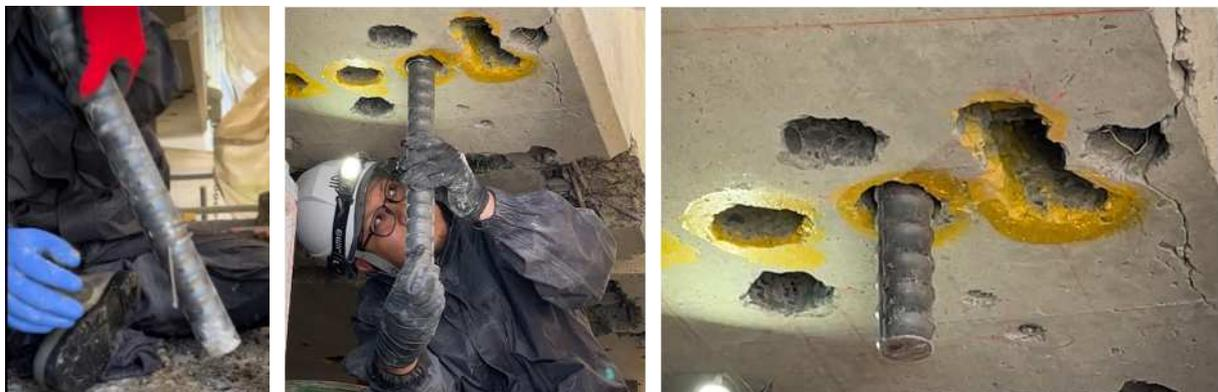
写真 2.3 留太郎Wの取付け状況と挿入後
